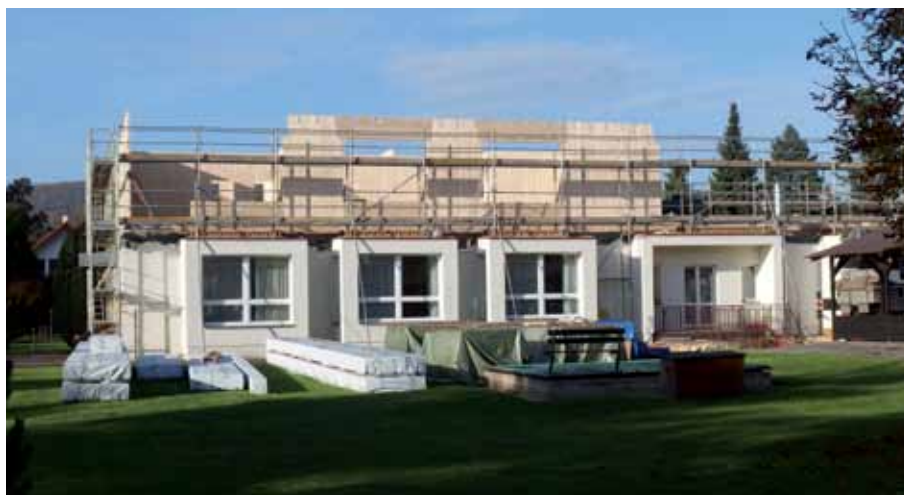
Takto stavba začínala. Nástavba na budově mateřské školy bude obsahovat dvě nové třídy.
