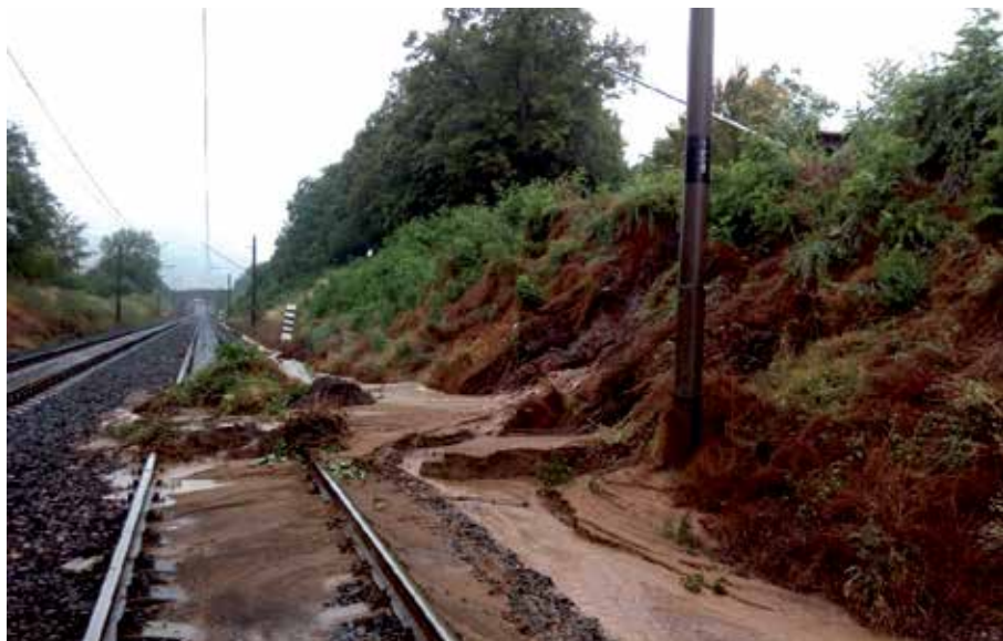
Bouřka s přívalem deštěm nahnula na jednu železniční kolej hlínu a kameny
