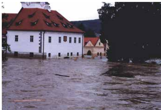
Přízemí zámku bylo celé pod vodou
