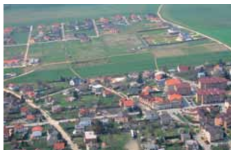
Příliš rozsáhlé plochy pro „čisté bydlení“, které nekompromisně požirají volnou krajinu v okolí Prahy.
