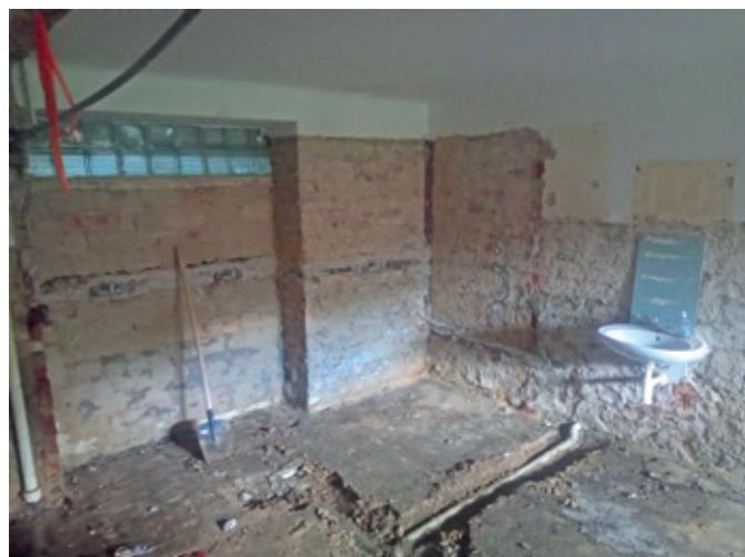
Rekonstrukce sociálního zázemí v areálu sokola pod pensionem
