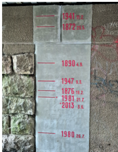
Povodňové značky v podjezdu do kempu
