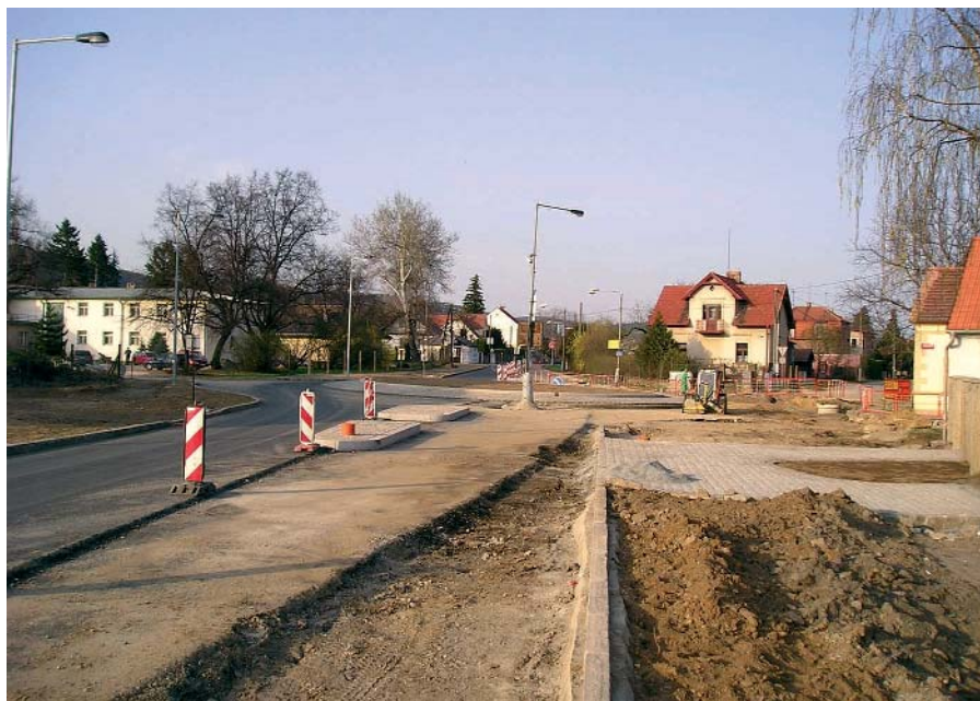
Stavba kruhové křižovatky u sokolovny se blíží k závěru
