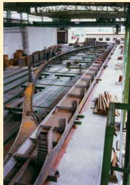
Červen 1996 – mostárna DT Prostějov – přejímka ocelové konstrukce
