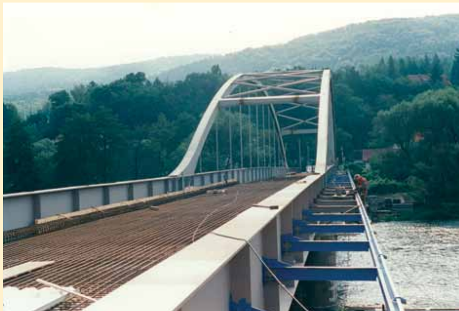
Září 1996 – montážní práce pomalu končí
