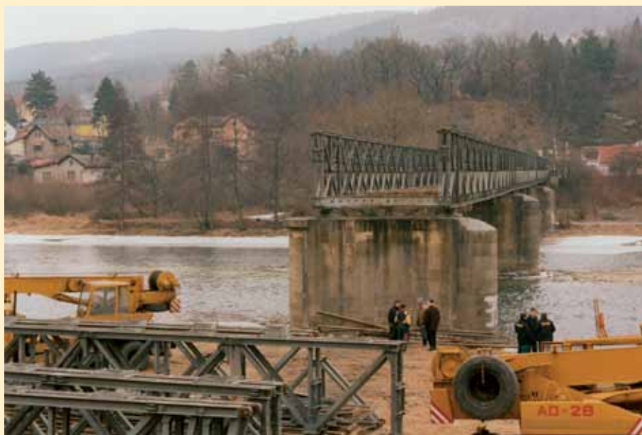
Březen 1996 – snímání provizorního mostu před zahájením stavby nového mostu
