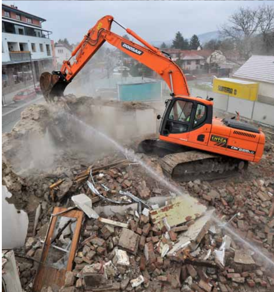
V polovině března byly zahájeny bourací práce školnického domku a části staré budovy stávající školy. Bourací práce by měly být dokončeny do začátku dubna. (foto Petr Kubín)
