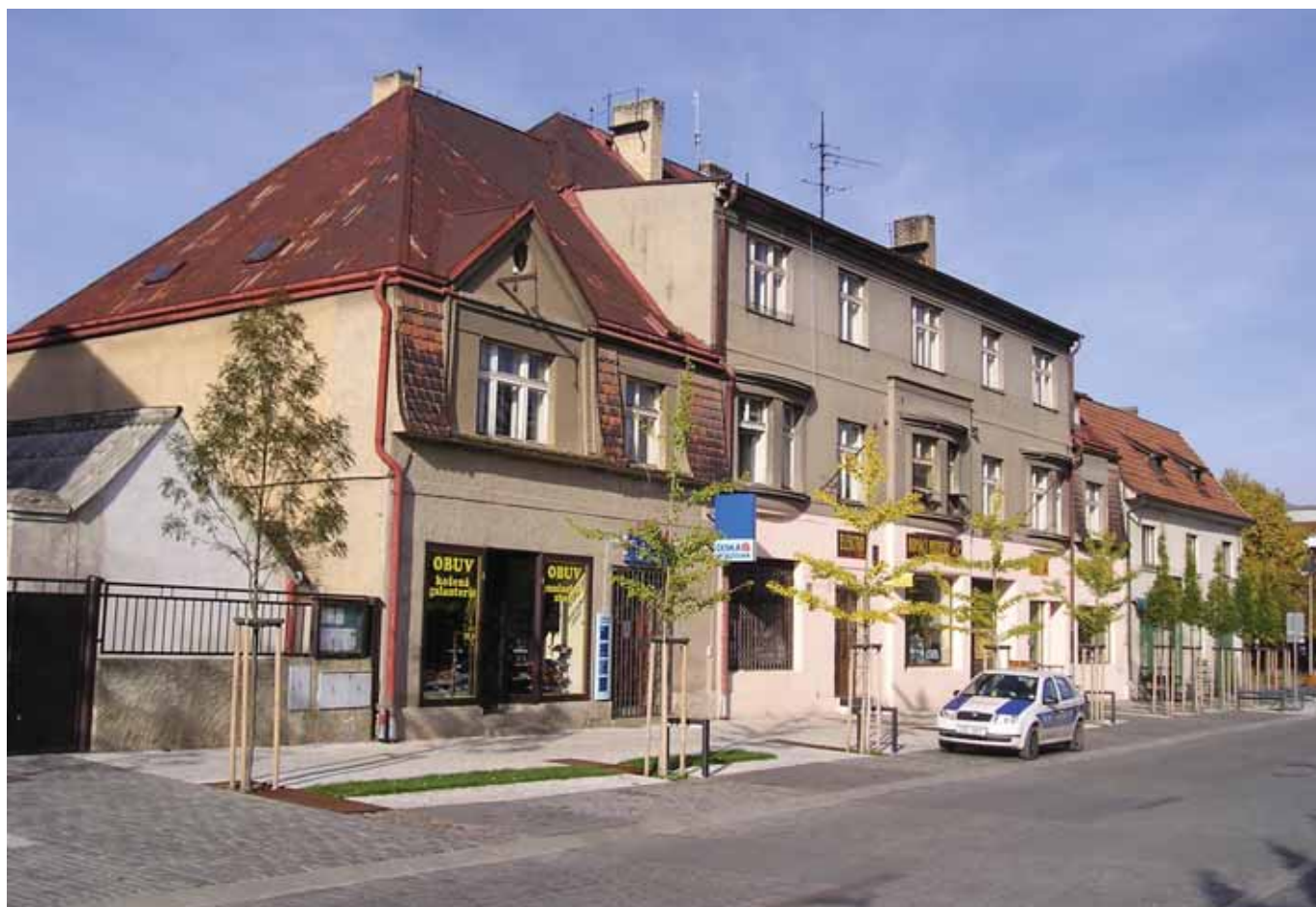
V centru vyrůstá nový dům na místě tří starých domů.
