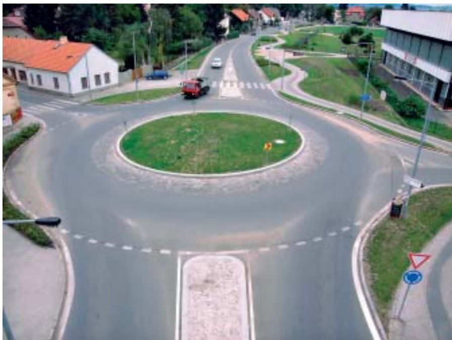
Kruhová křižovatka Pražská/Palackého změnila vzhled této části obce a zpomalila provoz. Foto Ekis, Ing. Pospíšil.
